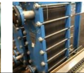
Warmtewisselaars, buis en plaat
